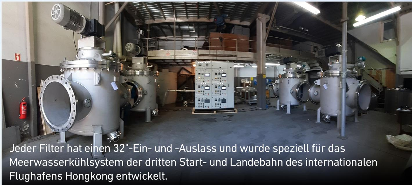
Jeder Filter hat einen 32"-Ein- und -Auslass und wurde speziell für das Meerwasserkühlsystem der dritten Start- und Landebahn des internationalen Flughafens Hongkong entwickelt.
