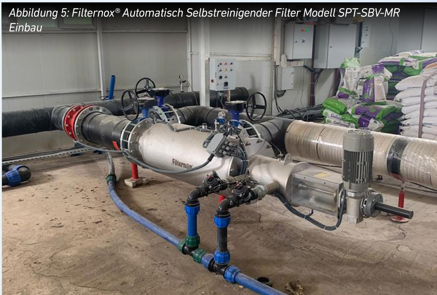
+ Das Modell SPT-SBV-MR ist eine unserer neuesten Filterentwicklungen und ist international patentiert. Er verfügt über einen kombinierten, zweistufigen Reinigungsmechanismus mit Bürsten und Vakuumdüsen und zwei separaten Entwässerungsventilen an seinem Gehäuse. Seine spezielle Technologie ermöglicht die Filtration von groben und feinen Schadstoffpartikeln in einer einzigen Filterkammer.
