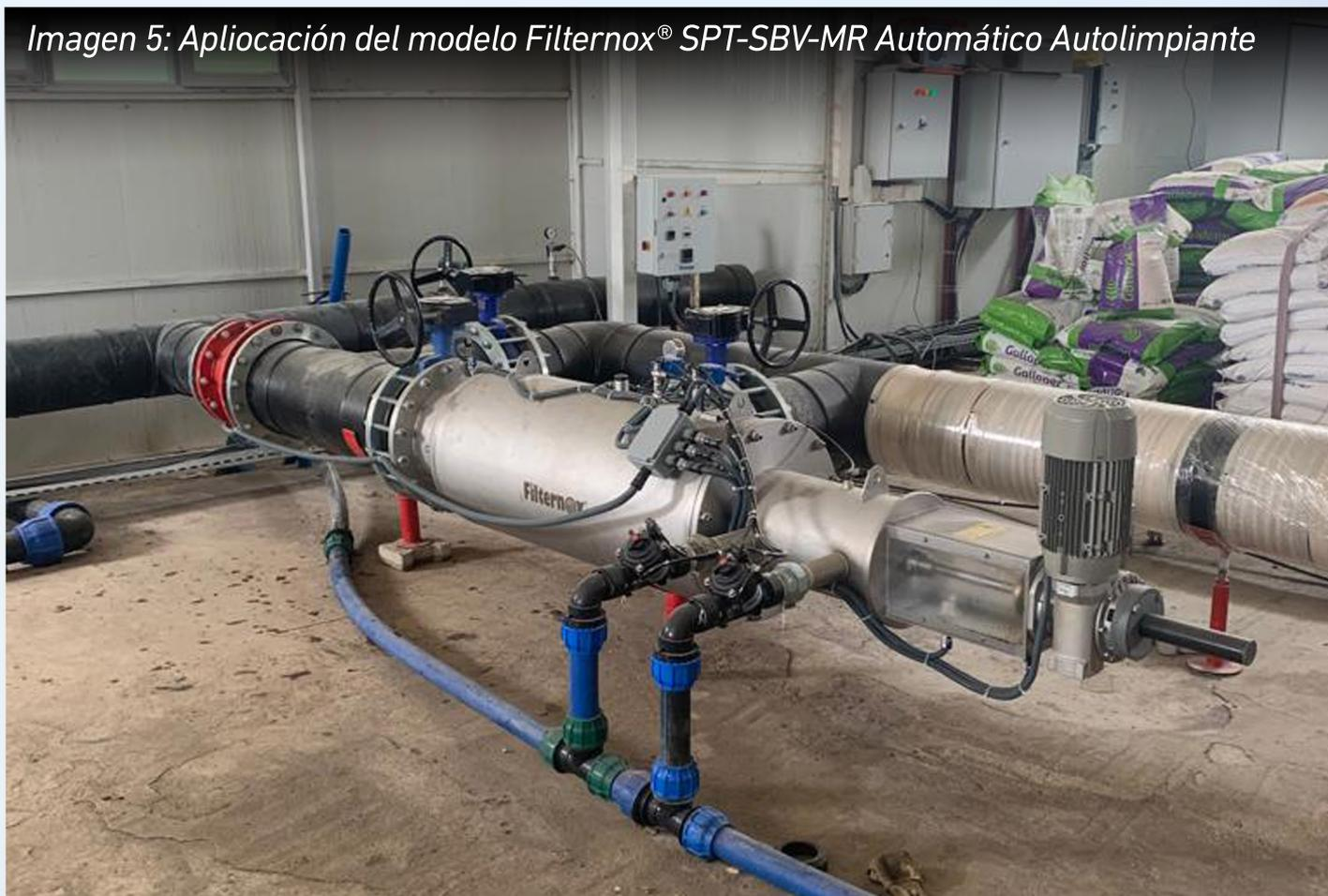
+El modelo SPT-SBV-MR es uno de nuestros desarrollos de filtros de última generación y está patentado internacionalmente. Tiene un mecanismo de limpieza combinado de dos etapas con cepillos y boquillas de vacío y dos válvulas de drenaje separadas en su cuerpo. Su tecnología específica permite la filtración de partículas contaminantes tanto gruesas como finas en una sola cámara.
