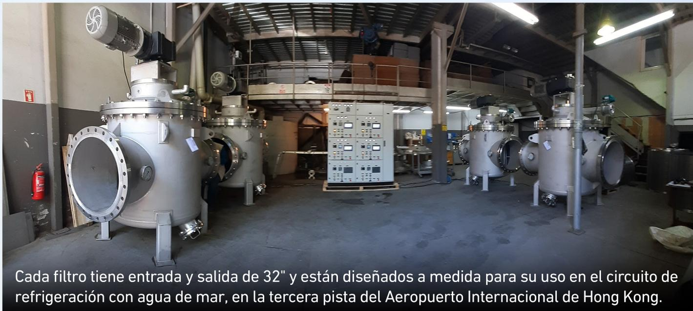
Cada filtro tiene entrada y salida de 32" y están diseñados a medida para su uso en el circuito de refrigeración con agua de mar, en la tercera pista del Aeropuerto Internacional de Hong Kong.
