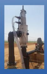
5. Aplicación del filtro modelo Filternox® SPT-WBV-MR para filtración de agua de pozo
