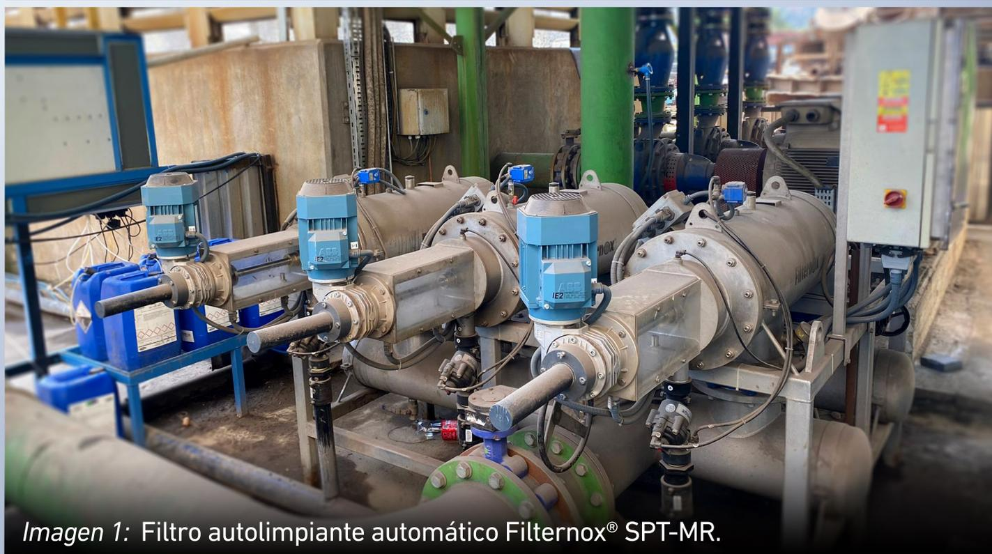
Imagen 1: Filtro autolimpiante automático Filternox<sup>®</sup> SPT-MR.
