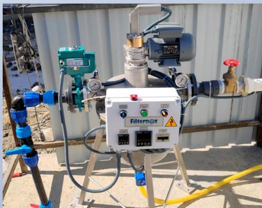
Fig.2 Filtro Filternox utilizado en estas instalaciones.
