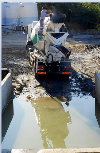
Fig.1 Agua y lodos procedente de la limpieza de la hormigonera con pistola de presión.
